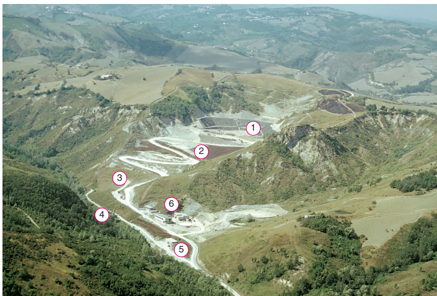
Impianto di smaltimento per rifiuti non pericolosi «Ginestreto», Sogliano al Rubicone (FC). Discarica ed impianti connessi: 1. area in coltivazione; 2. area già coltivata e in fase di recupero; 3. area di ripristino ambientale; 4. impianto di aspirazione del biogas e combustione in torce ad alta temperatura; 5. vasca di stoccaggio del percolato; 6. impianto di produzione di energia elettrica tramite il recupero del biogas
