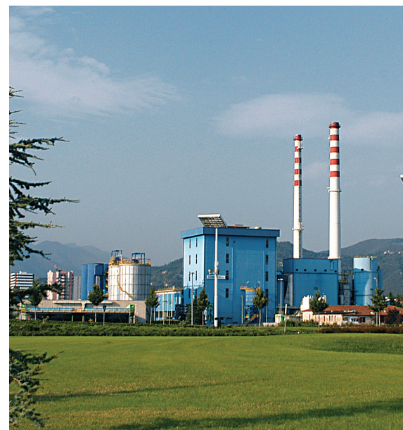
La storica centrale di cogenerazione «Lamarmora»
