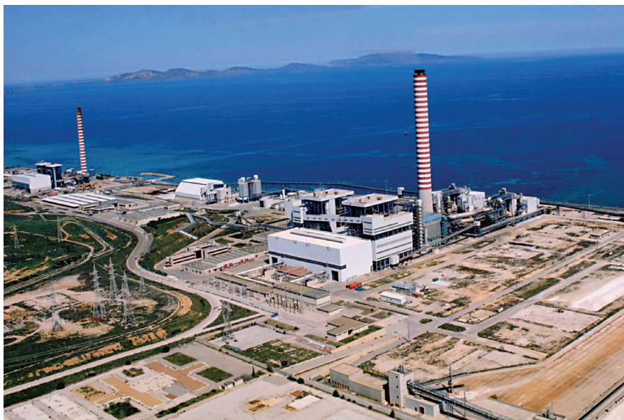
Centrale Termoelettrica di Fiume Santo (Sassari); in alto la Centrale Termoelettrica in repowering di Tavazzano-Montanaso (Lodi)
