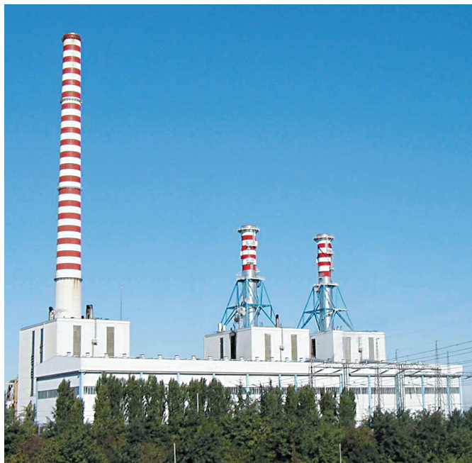
Centrale Termoelettrica a ciclo combinato di Ostiglia (Mantova)
