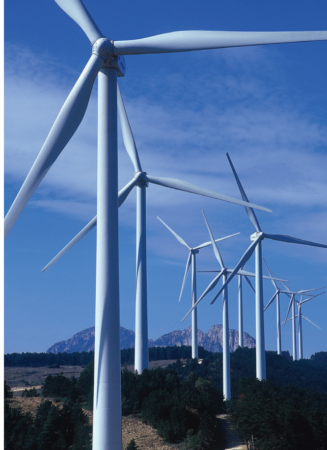
Parco eolico Escurillo (Spagna). 33 turbine GE 1,5 MW con capacità totale di 49,5 MW
