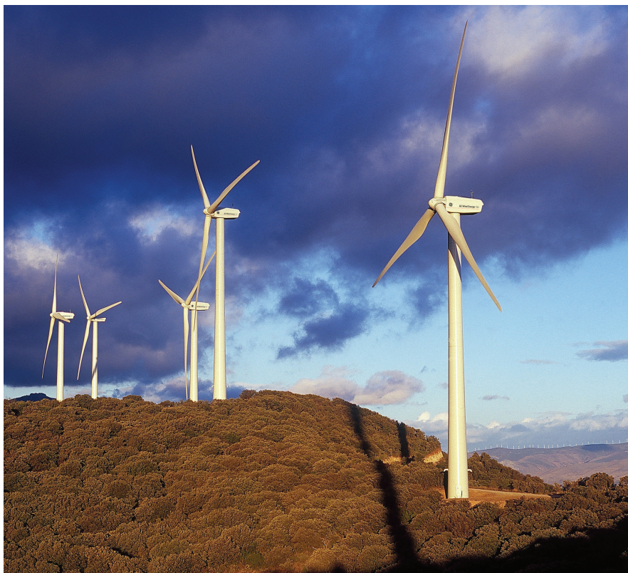
Parco Eolico Gattun (Spagna). 33 turbine GE 1,5 MW con capacità totale di 49,5 MW
