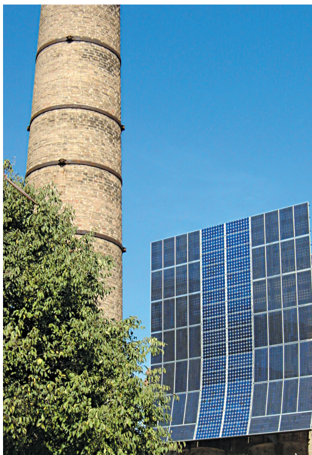
Fabrica del Sol a Barcellona; intervento di recupero e riabilitazione energetica di vecchio stabile industriale (arch. Antoni Solanas Cánovas)
