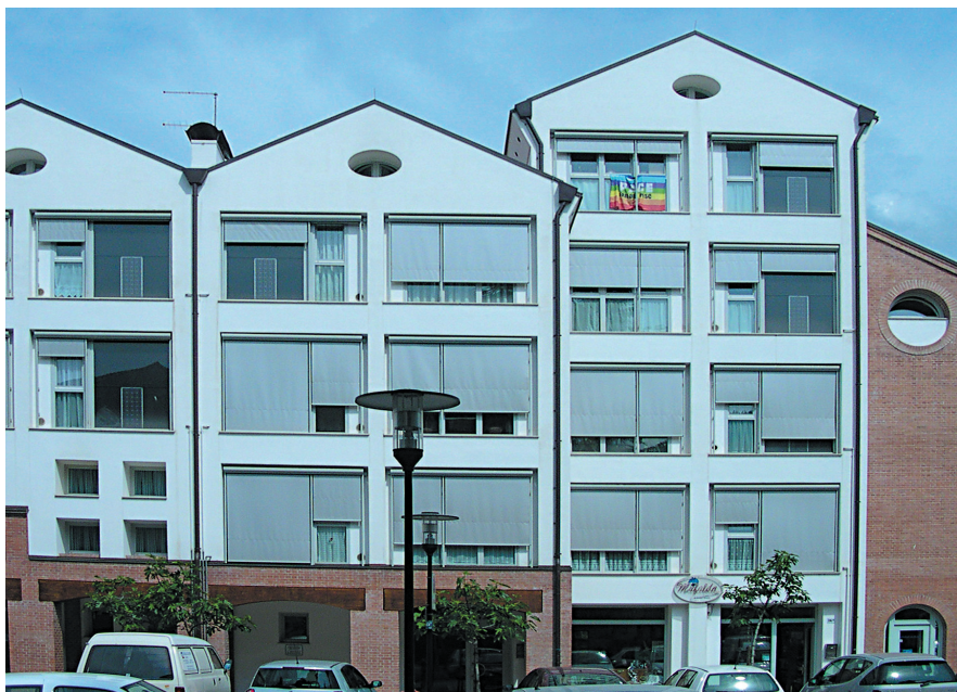
Condominio edilizia pubblica a Bolzano (1° premio Aniacap per l'Innovazione): cinque piani fuori terra in muratura portante. I pannelli solari ad aria in facciata sud contribuiscono al risparmio energetico (arch. Ugo Sasso)
