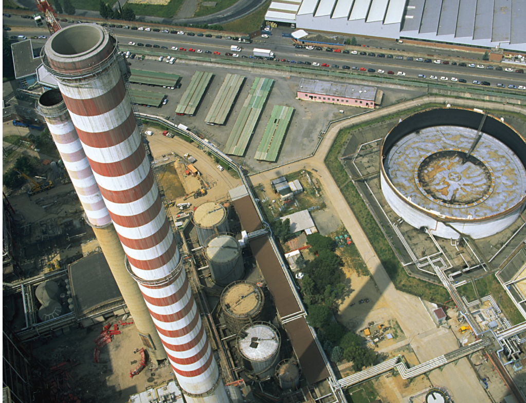
L'Italia investe sulle centrali elettriche di cogenerazione e stanZIA 37.500.000 euro per nuovi progetti. Centrale termoelettrica di La Spezia. [cortesia Enel/Fausto Quintavalle]
