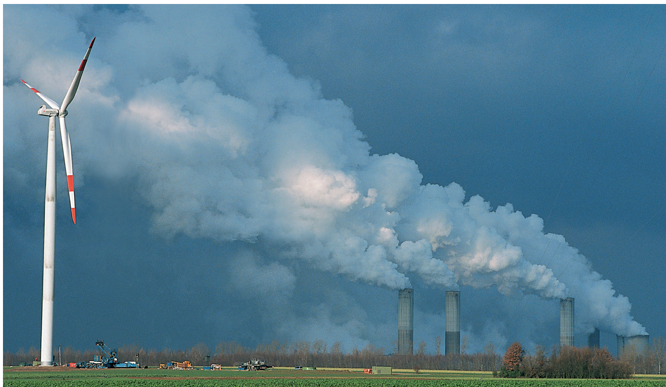
L'Italia scommette sull'energia pulita: grande attenzione all'eolico. Rotore eolico Neg Micon da 1,5 MW, installato a Grevenbroich (Germania). [cortesia ISES]
