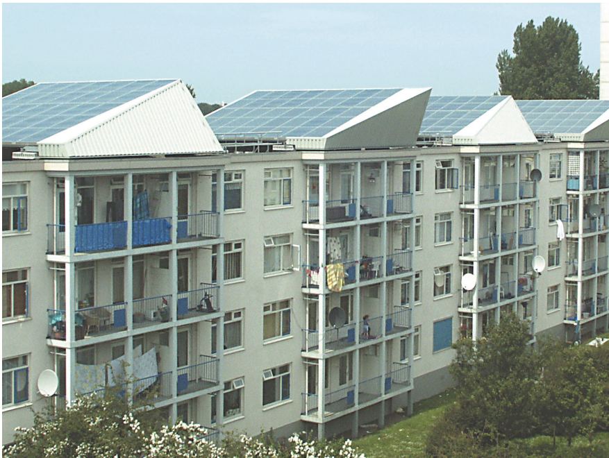
Complesso residenziale con tetti solari termici. In Germania 800.000 famiglie usano energia solare per riscaldare l'acqua per uso domestico. [© DFS]
