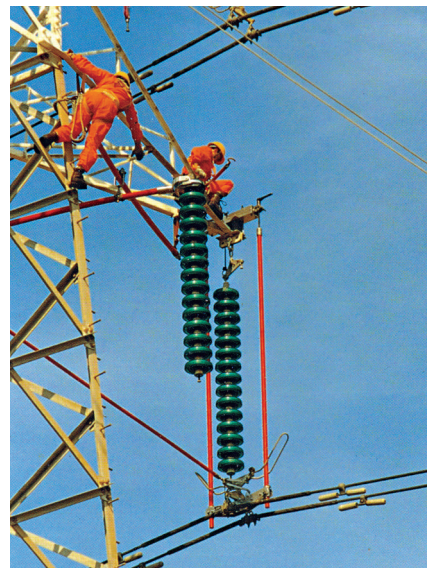
Gruppo di operai al lavoro su dei tralicci; sulla destra ben visibile una catena di isolatori in fase di montaggio. [cortesia ENEL]
