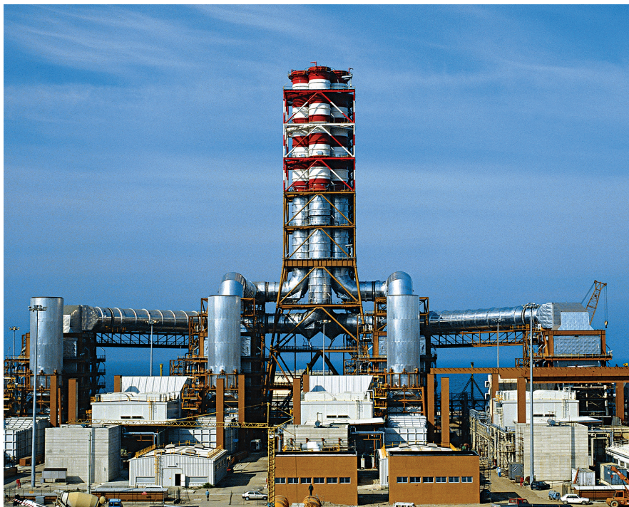
Centrale Termoelettrica di Rossano Calabro da 1.680 MW con alimentazione gas/olio. [cortesia Enel]
