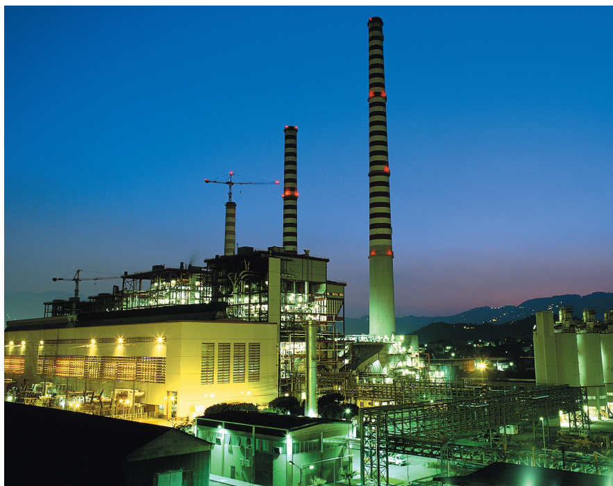
Una centrale termoelettrica. Una politica energetica e ambientale sbagliata avalla la tesi che sia necessario costruire numerosi nuovi impianti per rispondere alla domanda
