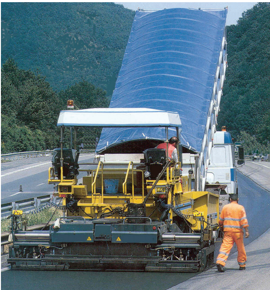
Rifacimento del manto stradale con il nuovo sistema che massimizza il riciclo del vecchio asfalto
