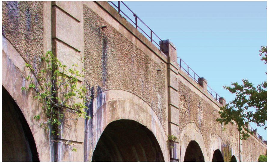
Particolare di un ponte canale dell'acquedotto
