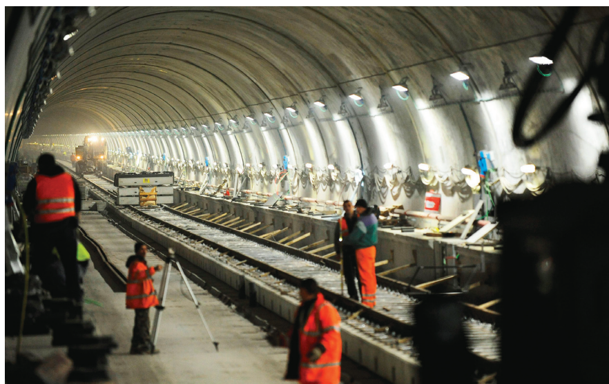
Il Cantiere MM3 nella tratta da Affori a Comasina
