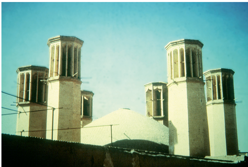
Torre del vento (Yazd, Iran). Spesso le torri del vento sono accoppiate a cupole forate in cima
