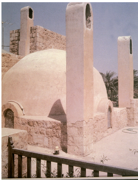
Foto A. Il camino a vento (malqaf) in una villa progettata in Arabia Saudita dall'architetto Hassan Fathy
