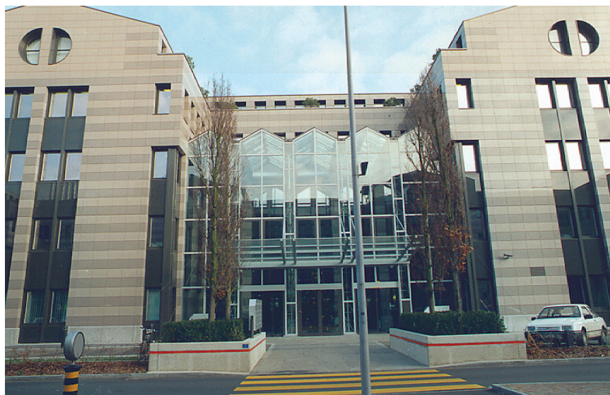
Sede di una banca svizzera nei pressi di Zurigo realizzata con tecniche proprie della bioclimatica come dimostra la serra inserita nel corpo centrale dell'edificio
