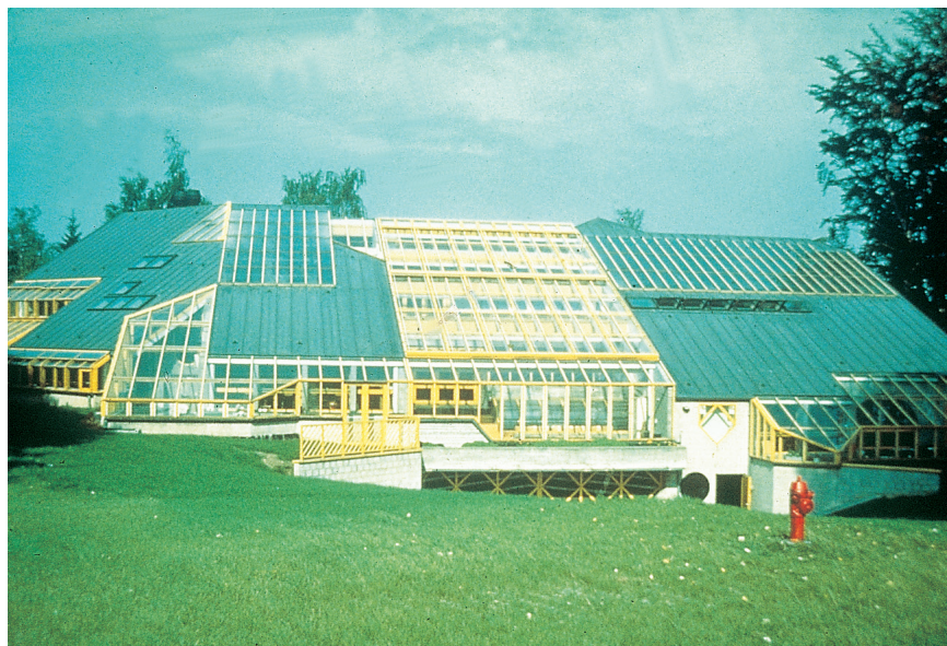
La «veranda serra» è uno dei modi più semplici per accumulare il calore del sole. L'esempio riportato si riferisce ad una scuola elementare del Belgio
