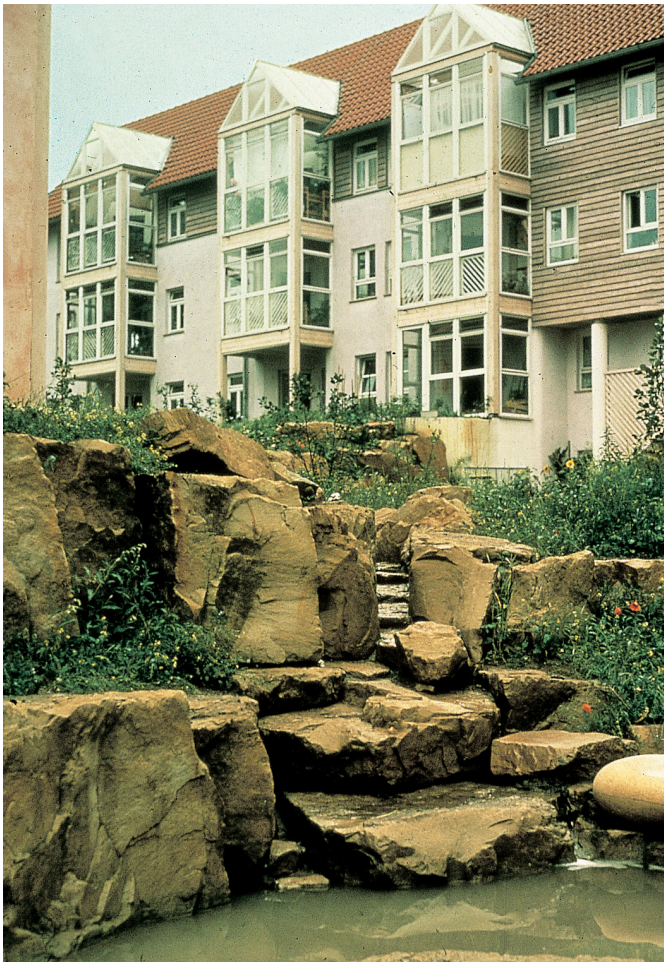
Schafbruehl, Tubinga, dell'architetto Joachim Eble. Il lotto si estende su 1,3 ettari e comprende 111 appartamenti più 102 posti auto. Viene recuperata l'acqua piovana per abbellimento esterno
