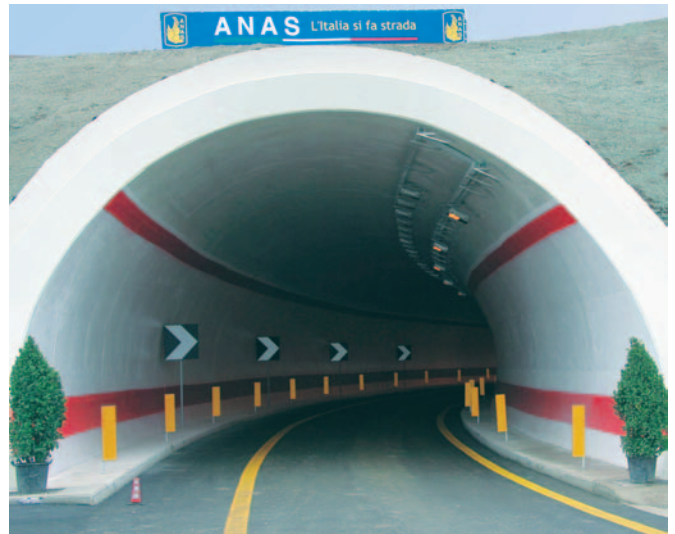
Una recente galleria dell'Anas progettata con ridotto impatto ambientale
