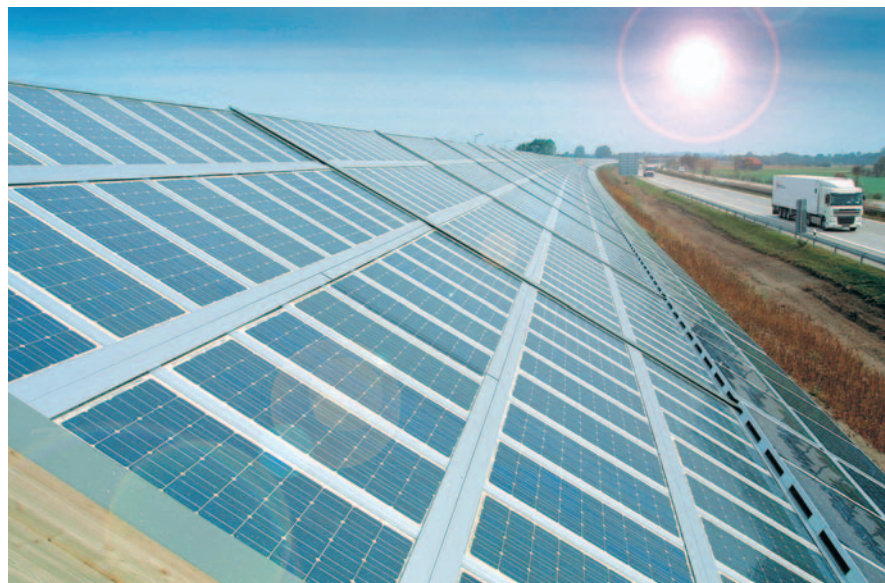
Quando l'infrastruttura stradale impone la realizzazione di grandi ed estesi terrapieni, l'inevitabile impatto visivo della grande superficie risultante può in compenso essere virtuosamente destinato alla produzione di energia elettrica CO 2 -free
