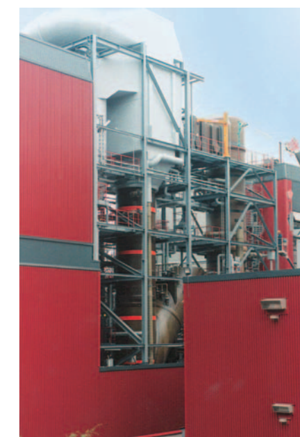
L'impianto di termovalorizzazione di Riihimäki in Finlandia è stato avviato nel 2007, brucia rifiuti solidi urbani con una capacità di 20,75 t/h. La tecnologia adottata è quella della griglia mobile raffreddata ad acqua
