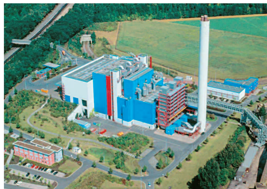
Impianto termovalorizzatore di Weisweiler - Germania
