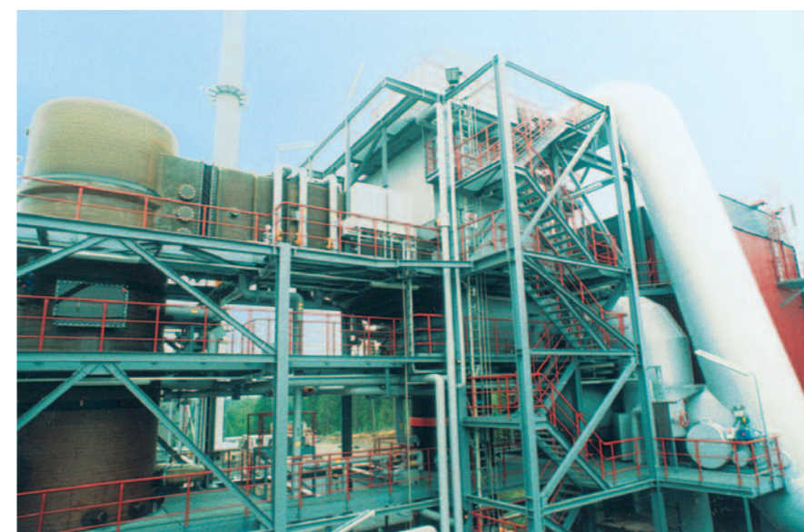
L'impianto di termovalorizzazione di Riihimäki in Finlandia è stato avviato nel 2007, brucia rifiuti solidi urbani con una capacità di 20,75 t/h. La tecnologia adottata è quella della griglia mobile raffreddata ad acqua
