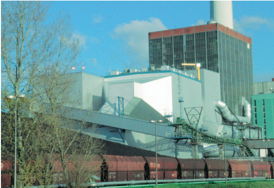
Impianto trattamento fumi di Mannheim - Germania
