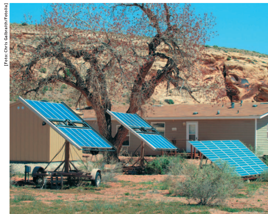
I pannelli fotovoltaici, lungi dal rappresentare una soluzione quantitativamente adeguata sul piano globale, si rivelano preziosi in località dalla forte insolazione e in cui realizzare le infrastrutture di trasporto dell'energia da centrali lontane comporta costi economici, ed energetici (quindi ambientali) molto elevati
